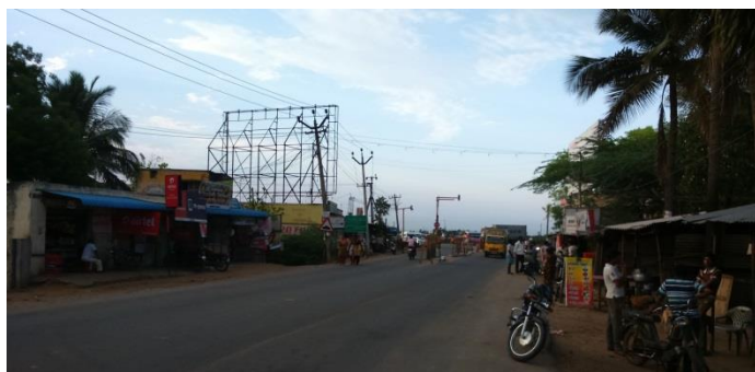
SH57とNH4との接続部分 ⇒ 拡幅工事はまだ未着工
