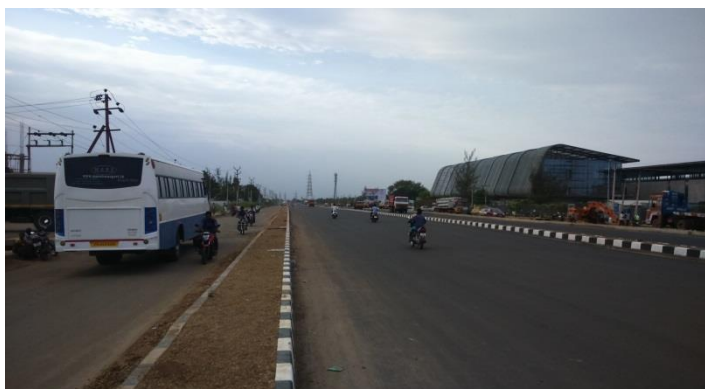
オラガダム交差点の北側部分における拡幅工事はほとんど完工
